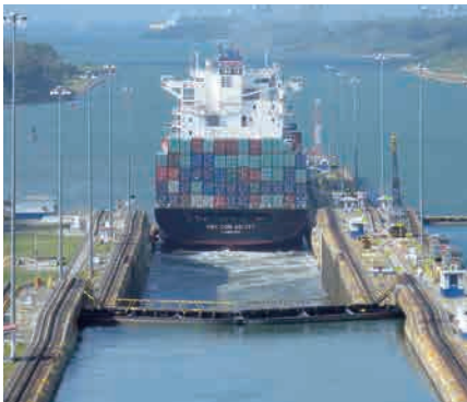
パナマ運河 水門設備
