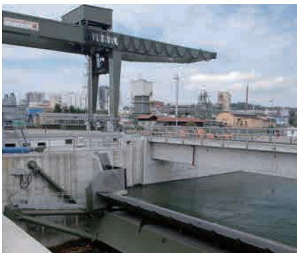
ドイツ ライン川発電設備
