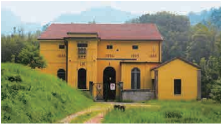
■ Ressaalto Puja 水力発電所 TURWADA SYNTH 46 / BIOGREASE EP 2
